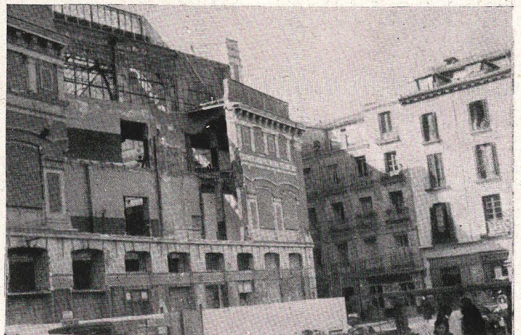
Demolición en fachada de la Plaza del Carmen para el gran pórtico de la entrada.
