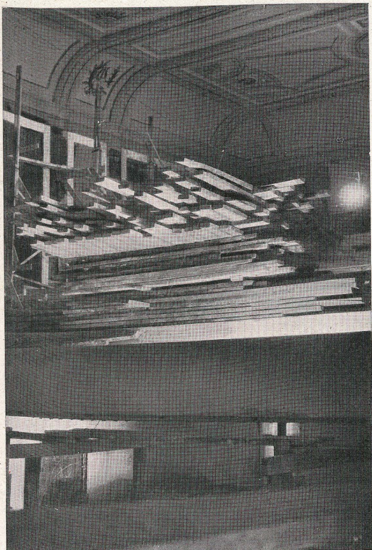
Una de las pruebas de resistencia de un pórtico del anfiteatro con una carga de 1.500 kilogramos por metro cuadrado.
