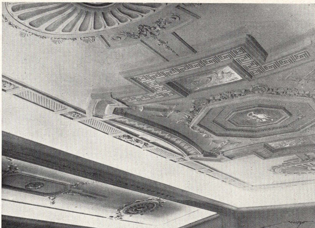
Techo de la Sala, bajo el anfiteatro, con rejillas de aspiración del aire viciado.
